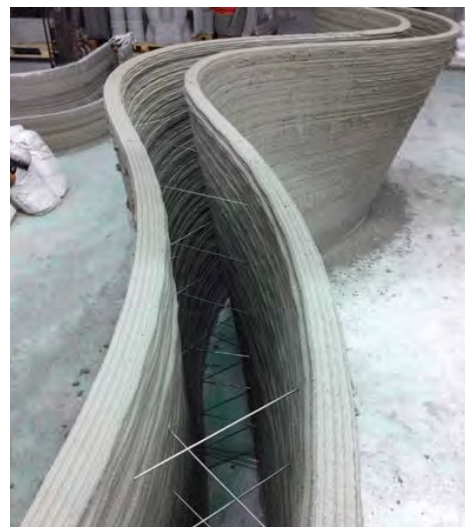
Fot. 12. Ściana wznoszona przez startup COBOD w technologii druku 3D
